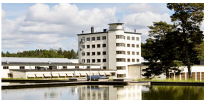
Lovö vattenverk. Foto: Kari Kohvakka/Stockholm Vatten.
