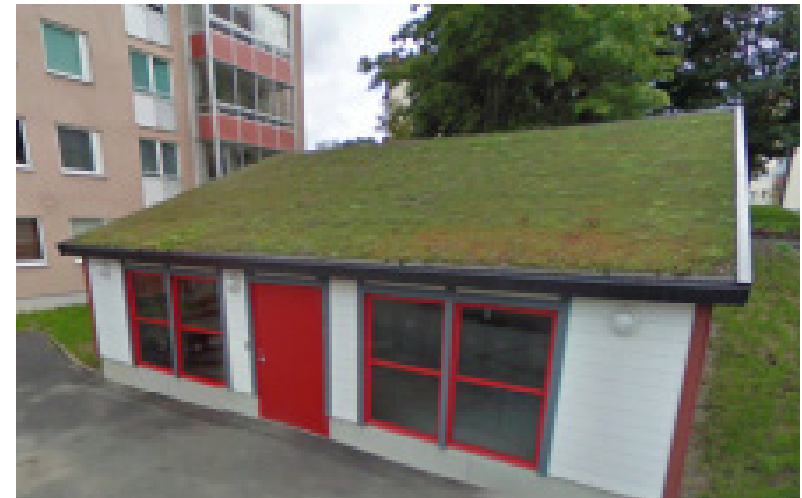
Exempel på komplementbyggnad med träpanel och sedumtak.
