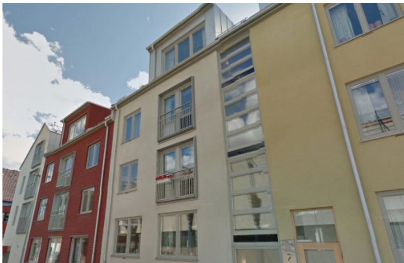
Exempel på förskjutning i takfot.
